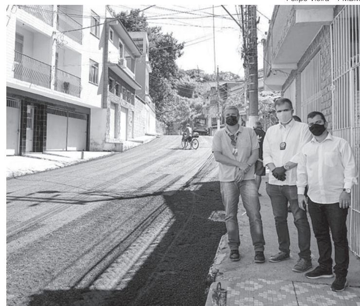
Drable e Furtado acompanham obra de asfaltamento da Rua São Jorge
